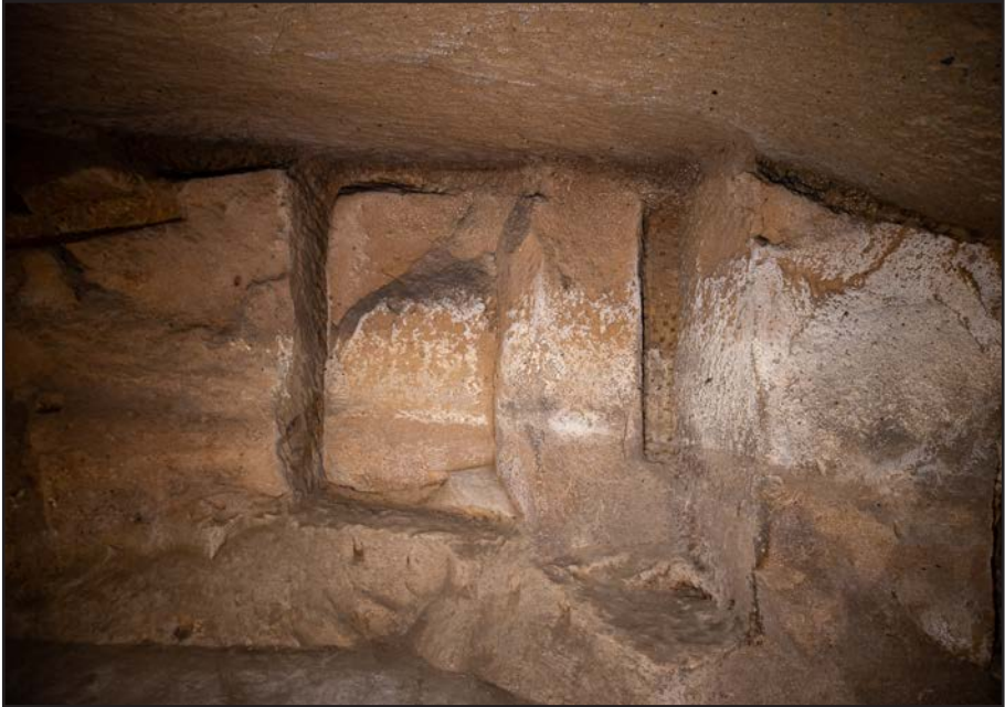
fig. 4 - Napoli, Via San Severo a Capodimonte n. 61. Cava (foto M. Palumbo).
