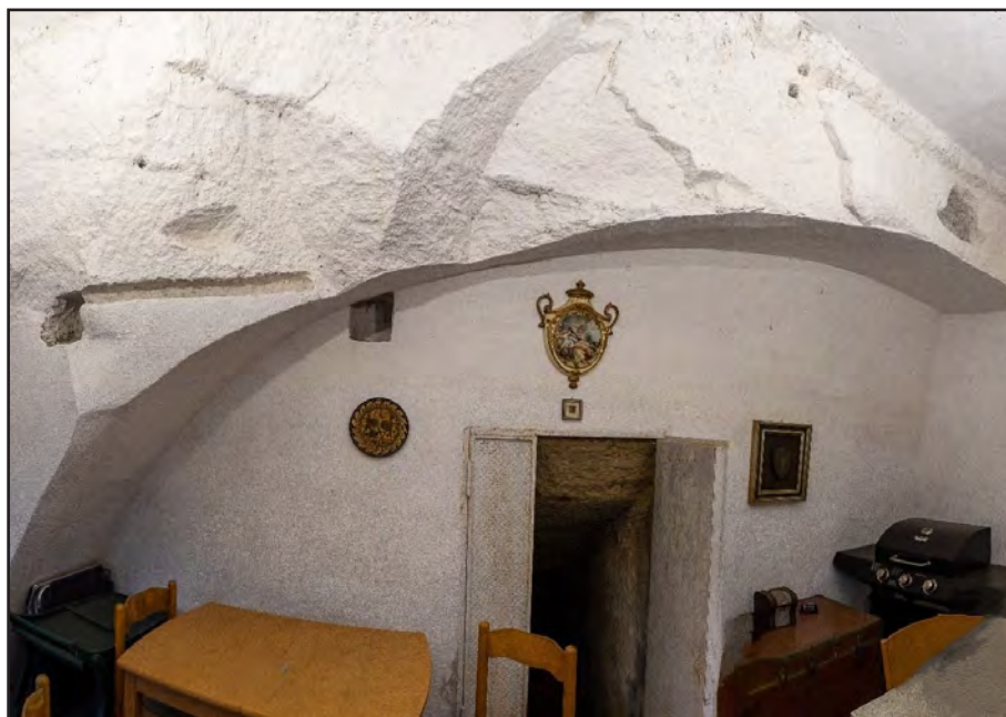
fig. 3 - Via San Severo a Capodimonte n. 61. Resti del lato ovest della volta (foto M. Palumbo).
